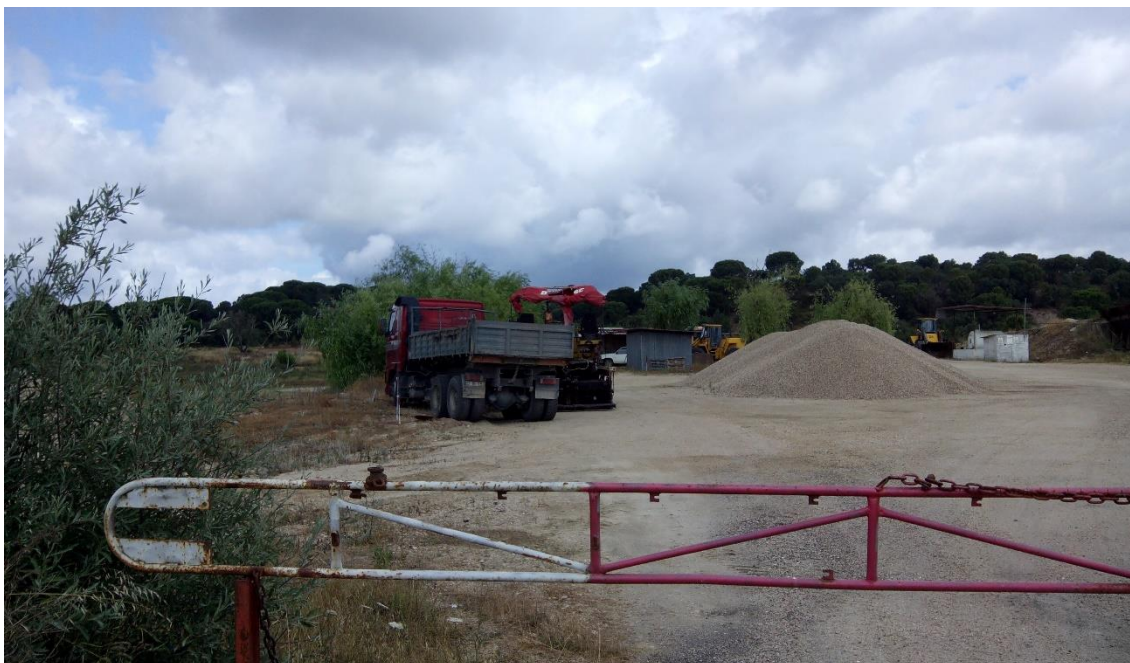
Figura 21- Vista da entrada do estaleiro de apoio à obra
